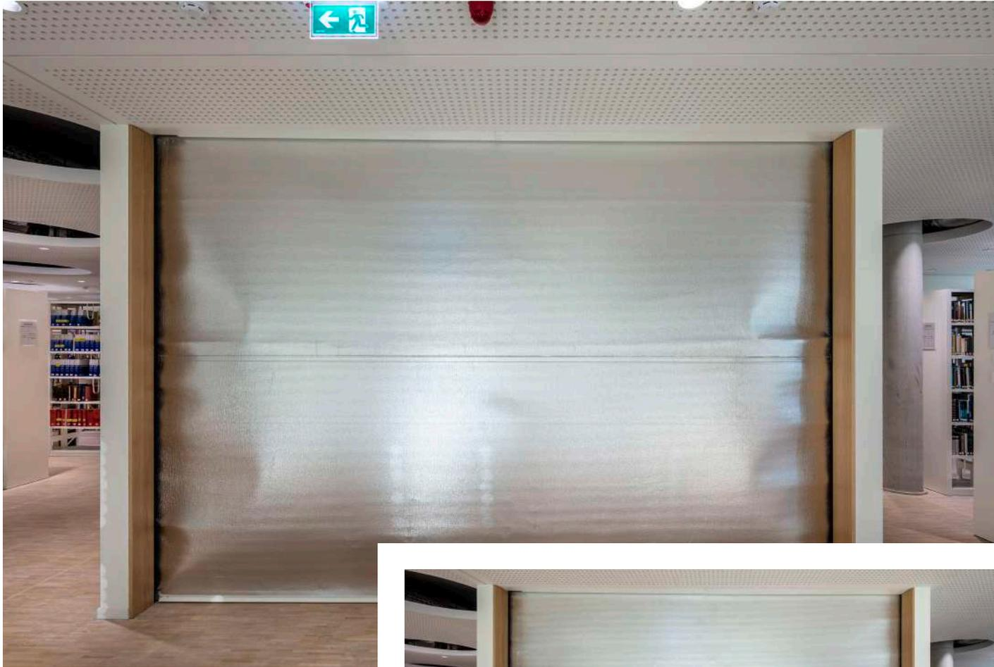
Mit Gravitationskraft verschließt das System Fibershield®-E den Treppenaufgang im Untergeschoss; die Wiederöffnung erfolgt motorisch (© Jörg Hempel Fotografie).
