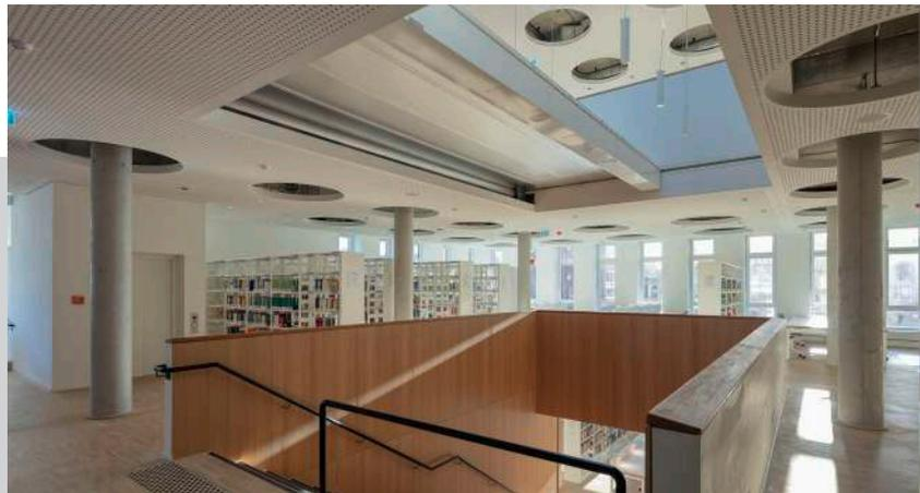
Tageslichteinfall und angenehme Luftzirkulation werden durch die offene Decke ermöglicht; die Gestaltungsfreiheit bleibt mit dem textilen Brandschutzelement uneingeschränkt erhalten.
